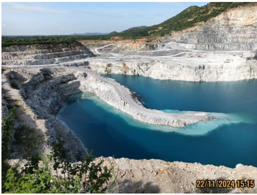
รูปที่ 3-13 บ่อตกตะกอน (ใช้ขุมเหมืองเก่า)
